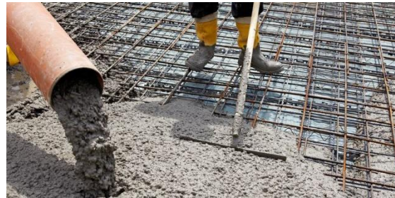
Figure 2: Béton armé en cours de préparation : coulage du béton sur une armature en acier.
